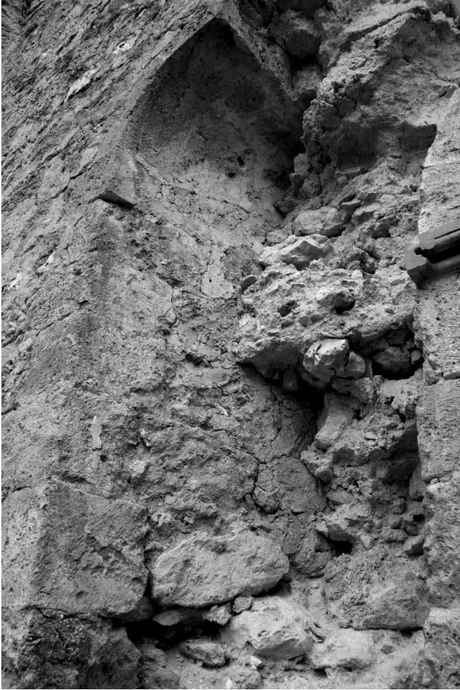
Figura 8.- Vestigios de un vano seccionado por la construcción del acceso a la capilla
