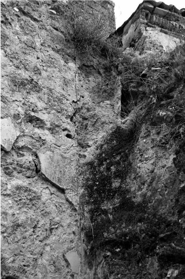
Figura 6.- Detalle del muro tapial
